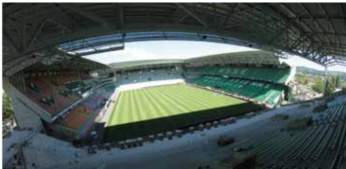
La rénovation et l'agrandissement du stade Geoffroy-Guichard à Saint-Etienne (2011-2014)
