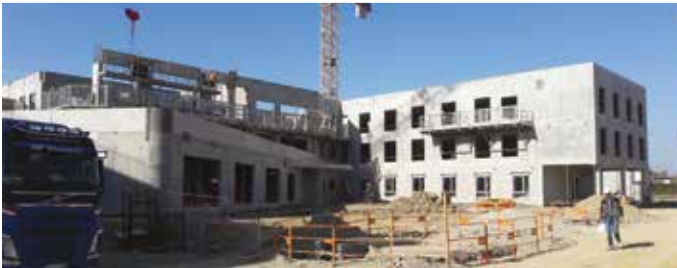
La construction de l'Hôpital de Belley (en cours)
