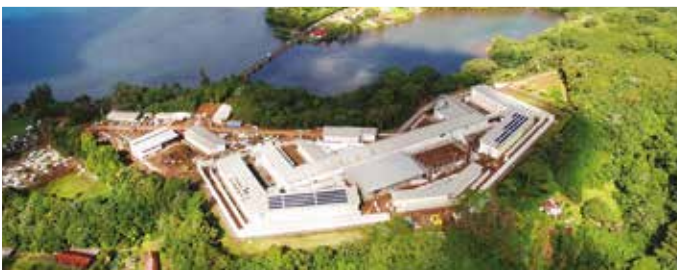
La construction de la prison de Papeari (2017)
