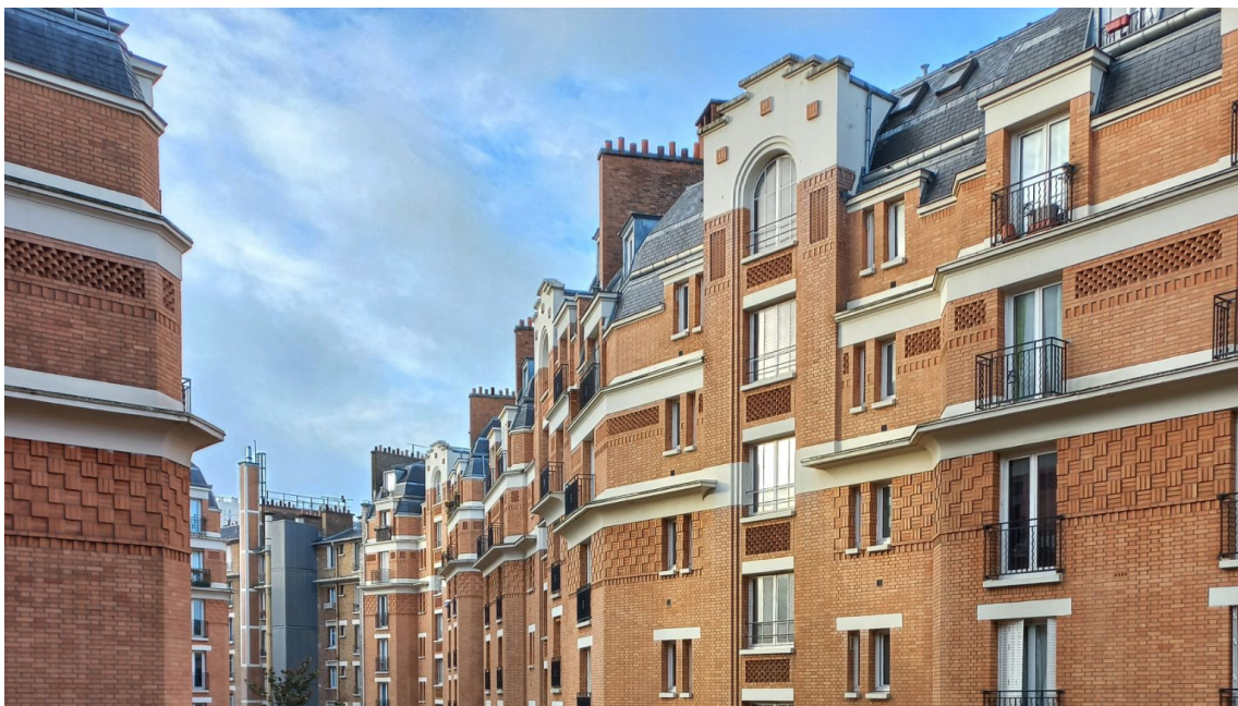
Rénovation en site occupé de 890 logements à la Porte Brunet à Paris
