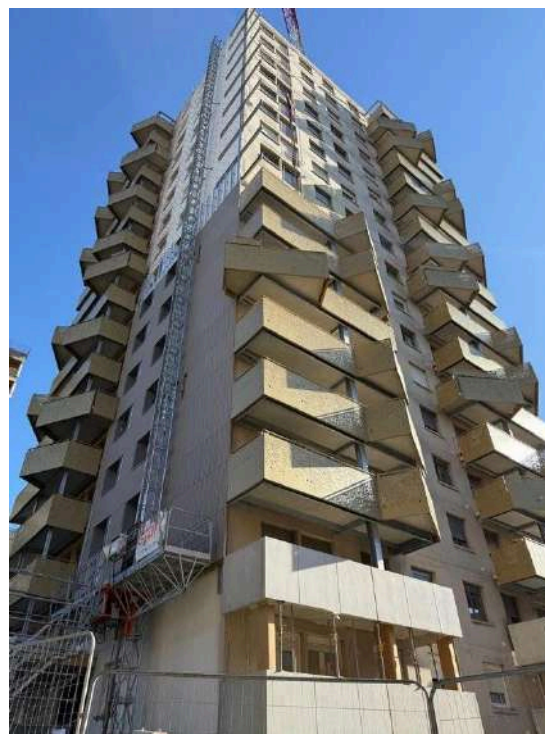
Pose des balcons et du bardage sur la tour 27 Alsace - © DR Léon Grosse
